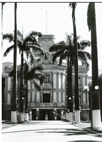
Fig. 201 Fotografia da fachada principal do Hospital Central do Exército. Fonte: Arquivo Geral da Cidade do Rio de Janeiro. (iconografia)
