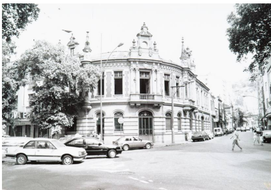
Fig. 198 Fachada Delegacia do Catete sem a cobertura original. Foto: Arquiteto Cláudio A. S. Lima Carlos, como cortesia em visita a obra com a autora em 1997
