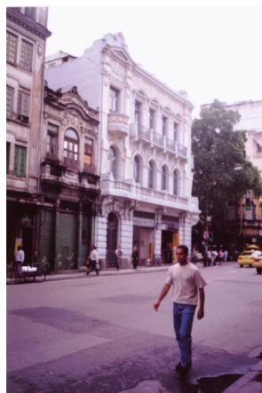
Fig. 178 Fotografia da fachada do Edifício Hermano da Silva Ramos. Foto: Alcione Terra / Out. 2002
